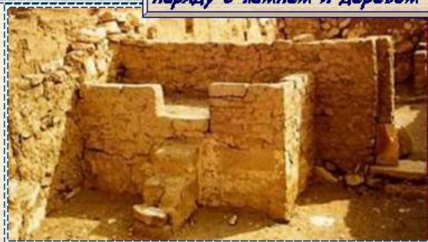
Саманный кирпич-сырец – многие века самый распространённый строительный материал наряду с камнем и деревом
