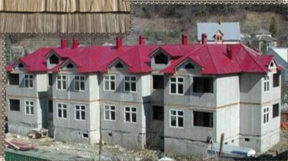
Постройка дома с применением цементно-стружечных плит
