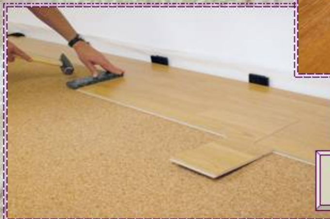
Укладка подложки под ламинат
